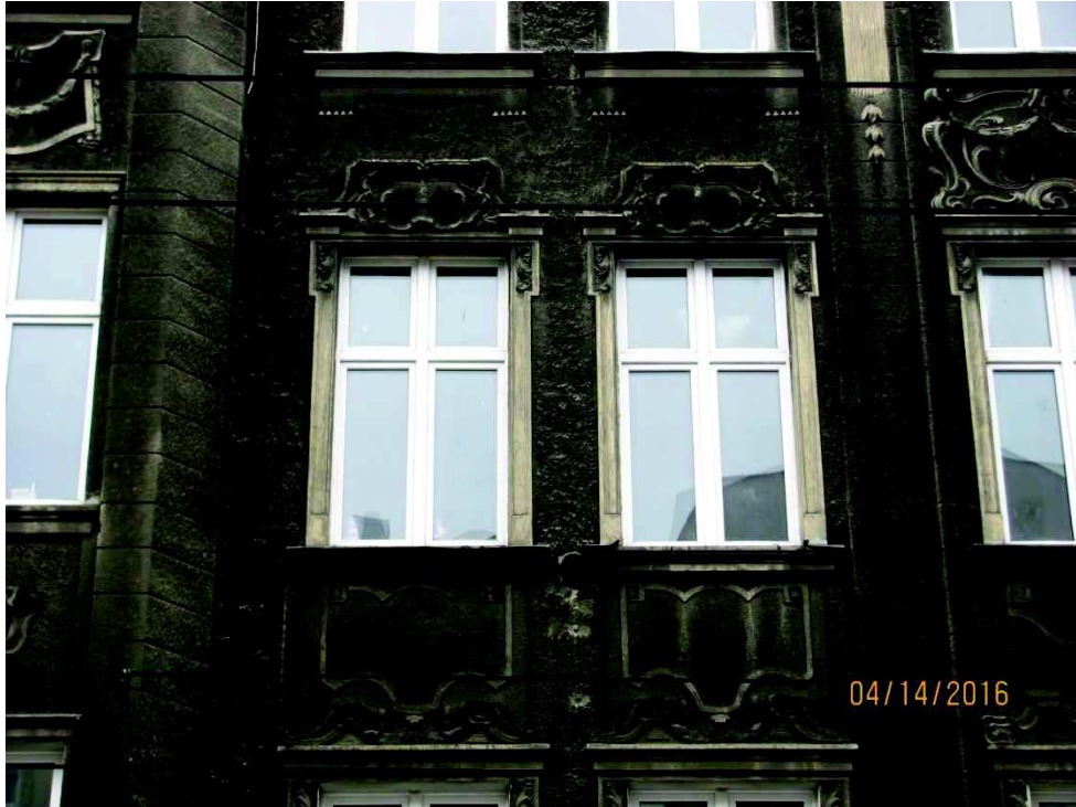
Rys. 17 Fragment elewacji frontowej z widocznymi naczólkami, należy usunąć wtórny tynk nakrapiany, szczegół – pozycja nr 6, oraz nr 7, źródło własne
