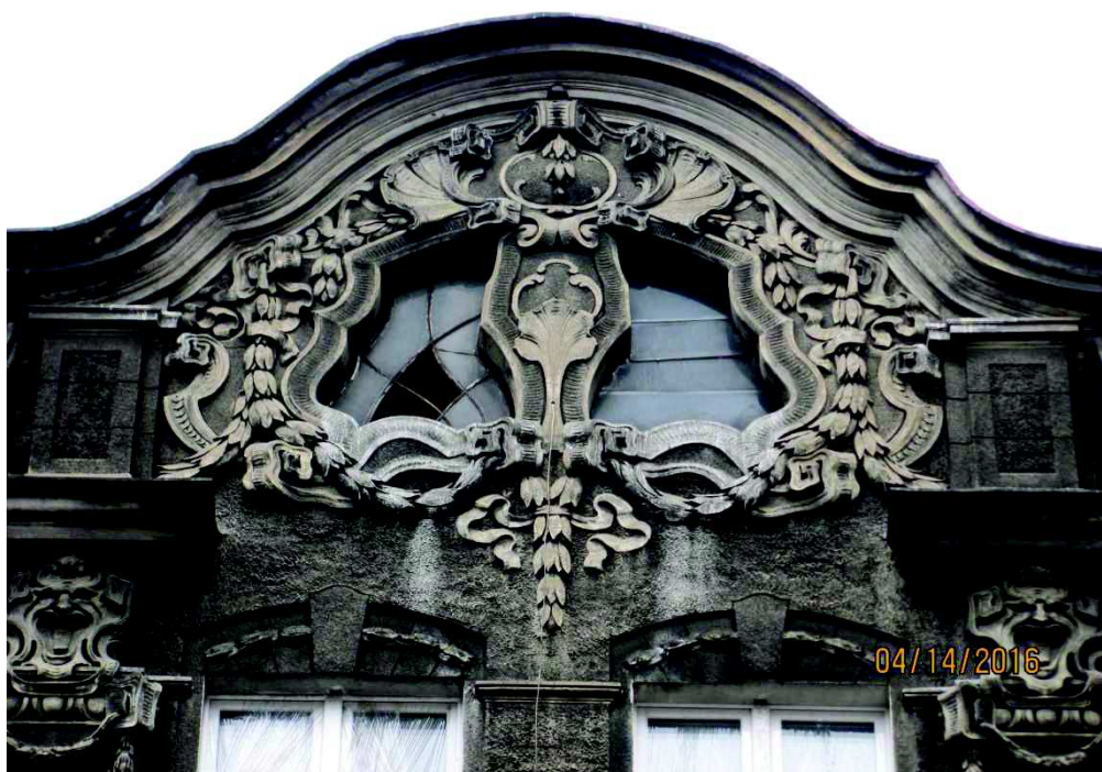
Rys. Okno na poddaszu wraz ze zdobieniami sztukatorskimi, należy usunąć wtórny tynk nakrapiany, szczegól – pozycja nr 4, źródło własne
