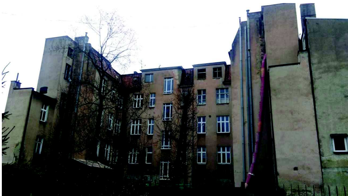
Rys. 5 Elewacja tylna i boczna kamienicy, źródło własne
