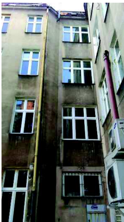
Rys. 11 Fragment elewacji północnej (wewnętrznej) z wymienionymi oknami PVC przed wykonaniem remontu elewacji kamienicy, źródło własne
