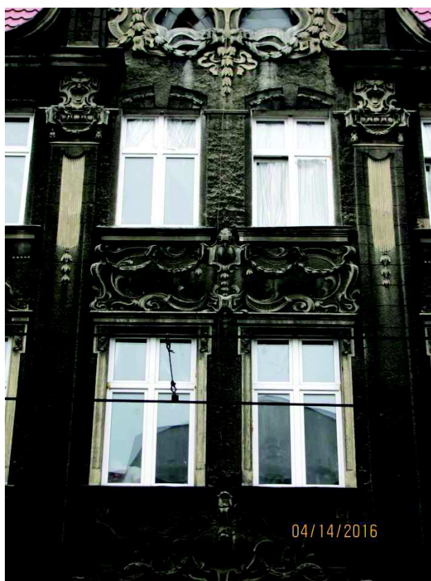
Rys. 16 Fragment elewacji frontowej wraz ze zdobieniami sztukatorskimi, należy usunąć wtórny tynk nakrapiany, źródło własne
