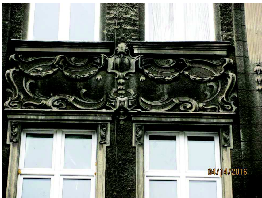
Rys. 15 Zdobienia sztukatorskie nad oknami na 2 piętrze, należy usunąć wtórny tynk nakrapiany, szczegół – pozycja nr 3, źródło własne
