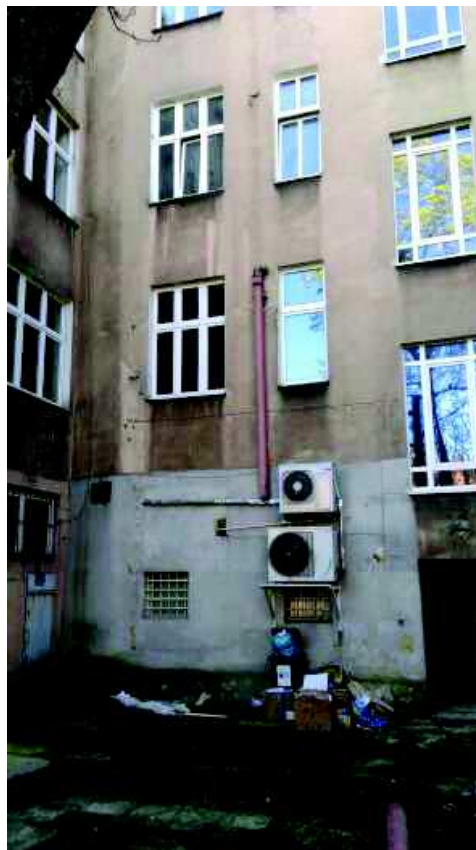
Rys. 10 Fragment elewacji zachodniej, źródło własne
