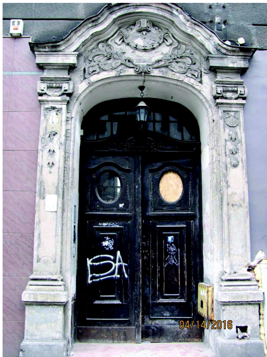
Rys. 13 Drzwi wejściowe na fasadzie kamienicy wraz ze sztukaterią na opasce drzwiowej oraz naczółek nad drzwiami, szczegół - pozycja nr 1, źródło własne
