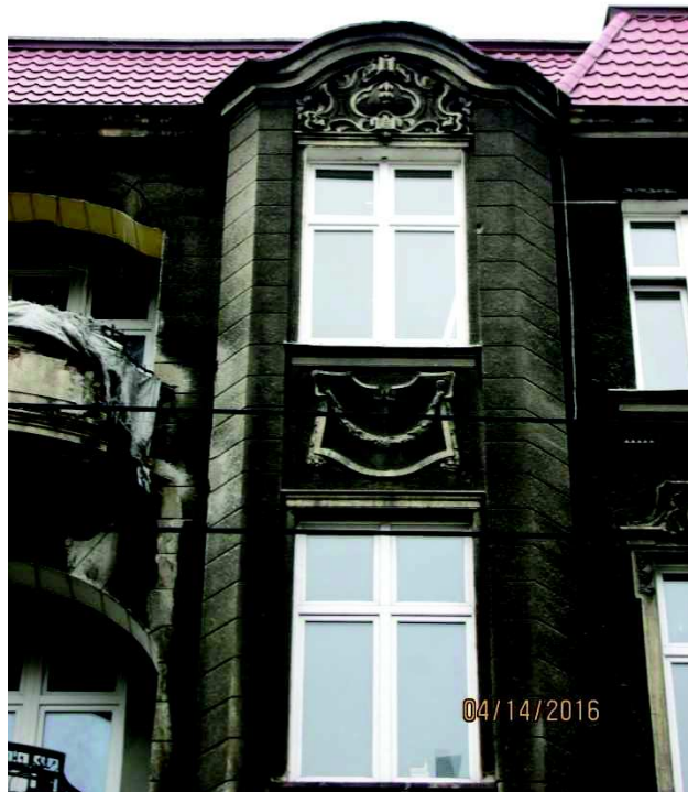
Rys. 18 Fragment elewacji frontowej wraz ze zdobieniami sztukatorskimi, szczegół – pozycja nr 9, źródło własne
