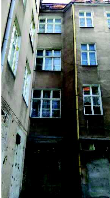
Rys. 7 Fragment elewacji tylnej z widocznymi pęknięciami na elewacji oraz stolarką okienną, źródło własne
