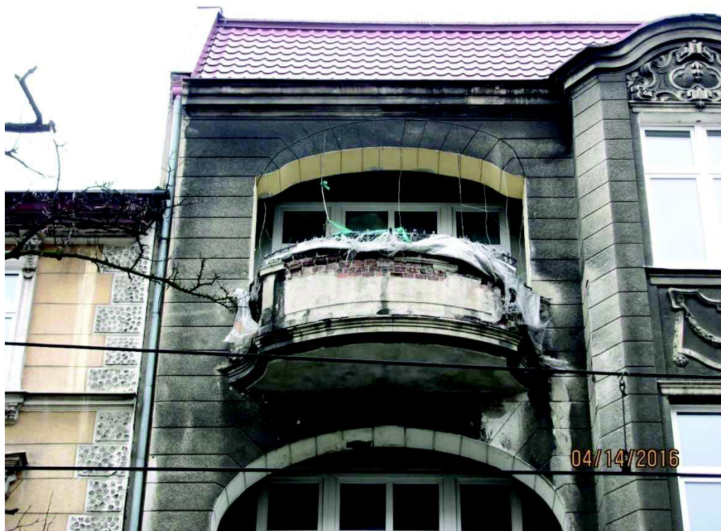
Rys. 21 Balkon na 3 piętrze z widocznymi sztukateriami na betonowej balustradzie, szczegół – pozycja nr 13, źródło własne
