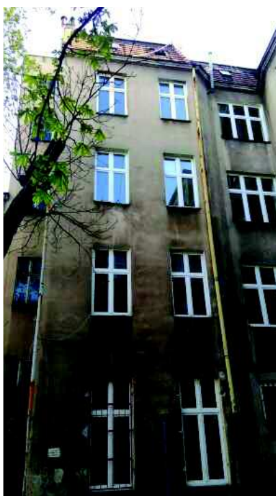
Rys. 12 Fragment elewacji północnej (zewnątrznej) z wymienionymi oknami PVC przed wykonaniem remontu elewacji kamienicy, źródło własne
