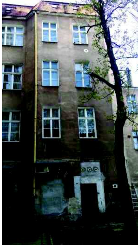
Rys. 8 Fragment elewacji południowej (wewnętrznej) z widocznymi uszkodzeniami przy drzwiach wejściowych technicznych, źródło własne
